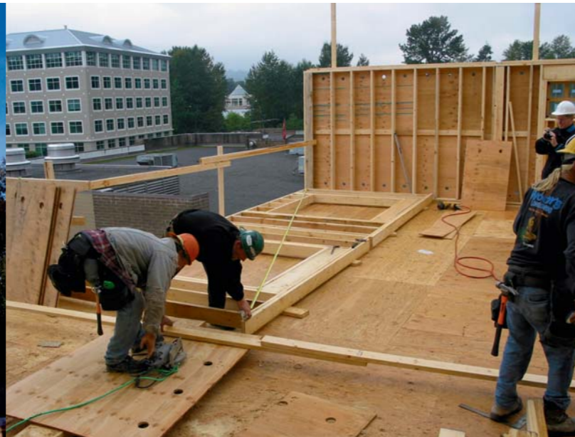
▲ Enamik Põhja-Ameerika elamuid ehitatakse platvormmeetodil ja puidust.
