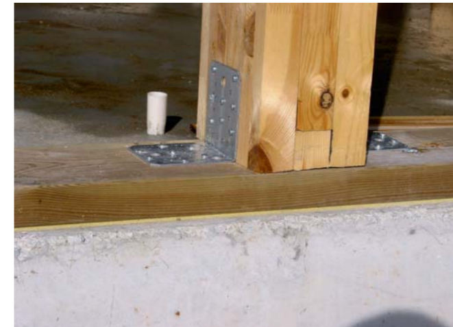
▲ Vundamendile toetuv võõpruss peaks olema immutatud, vundamenti ja võõprussi vahel tuleb kasutada spetsiaalset tihendusriba.
