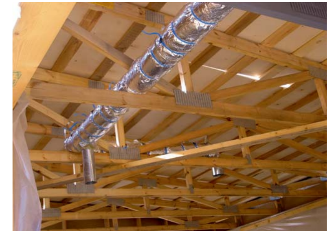
▲ Katuslae ogaplaatfermidesse saab paigutada ventilatsiooni-torustiku ja muudki.
