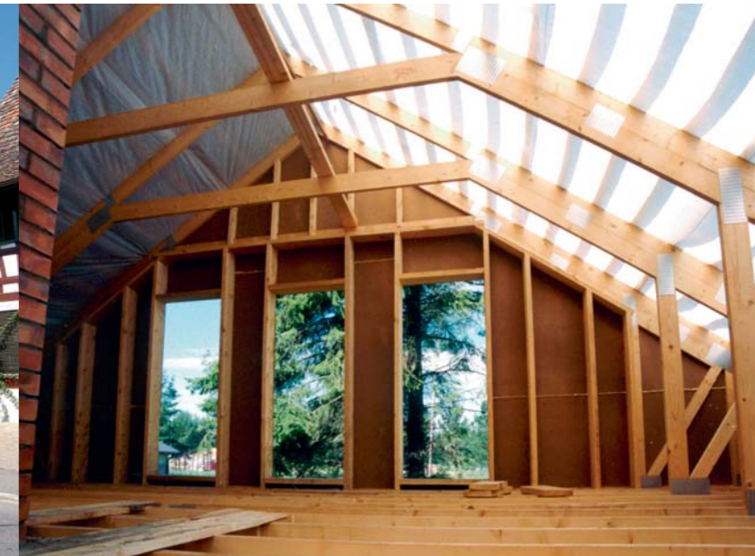
▲ Mansardkorruse saab ehitada ogaplaatsõrestiku sisse.
