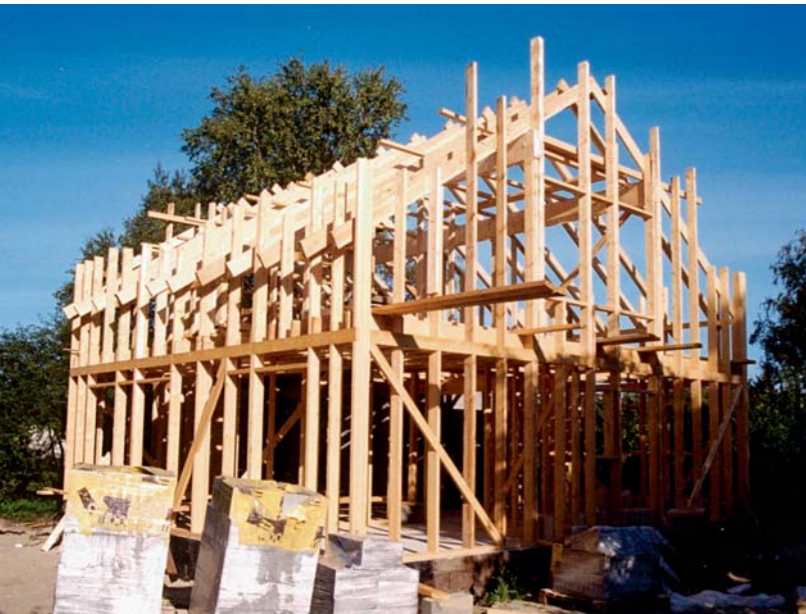
▲ Kahekorruselise mansardkorrusega puitkarkassmaja ehitamine.
