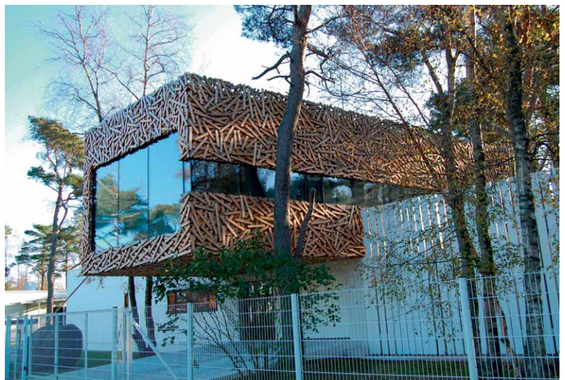
▲ Eramu juurdeehitus Suurupis. Puitfassaad koosneb neljast kihist hoolikalt kavandatud paigutusega lehiselipidest.
