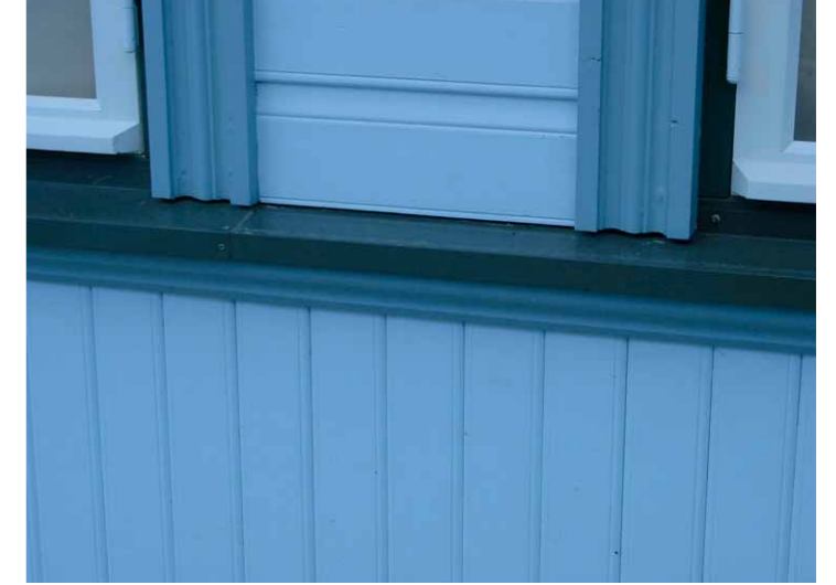
▲ Et õhk pääseks tuulutusvahesse, piisab 5–10 mm pilust veepleki pinna ja laudade otste või serva vahel. See laseb niiskusel piirdeliistude otstest ja laua alumisest servast välja kuivada ega ole silmale häiriv vaadata.
