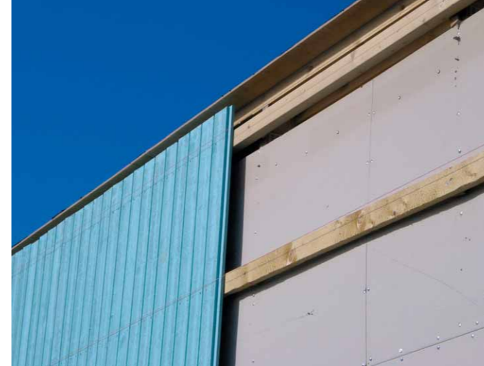
▲ Tehases värvitud voodrilaudade paigaldamine. Püstvoodri puhul kasutatav horisontaalne roovitis sulgeks õhu liikumise tuulutusvahes, selle vältimiseks on roovlattide alla paigutatud klotsid.
